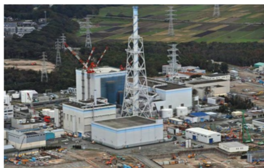
安全対策工事中の東海第二原発
