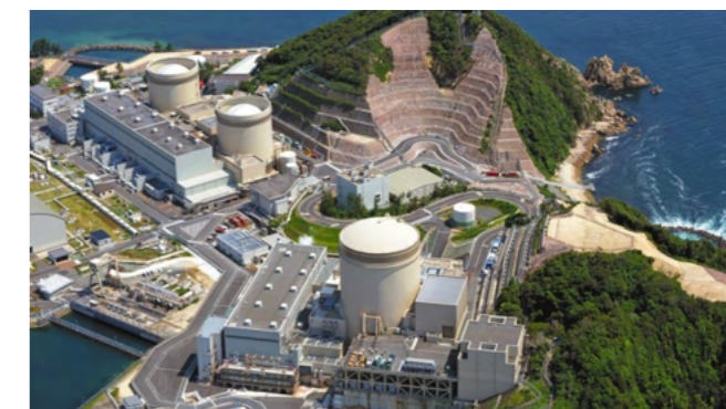
40年超えで再稼働した美浜原発3号機（手前）
