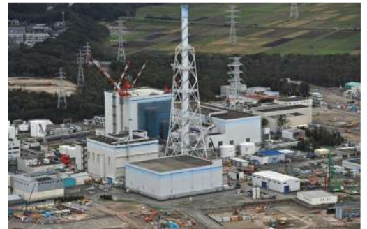
安全対策工事中の東海第二原発
